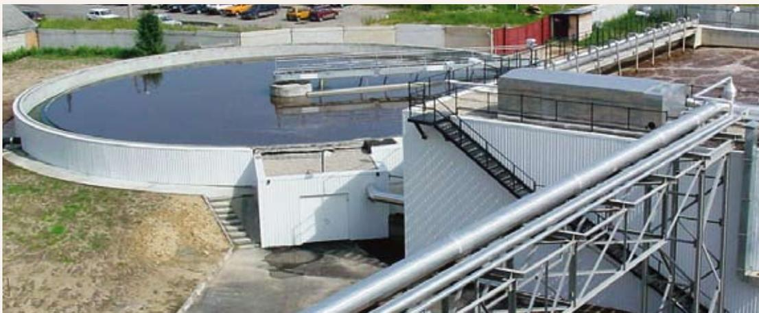
*покрытие Bolted Lining, которое обеспечит более эффективную защиту резервуаров системы от коррозии бетона. В результате емкости очистных сооружений будут на долгие годы застрахованы от разрушительного воздействия коррозии.*
