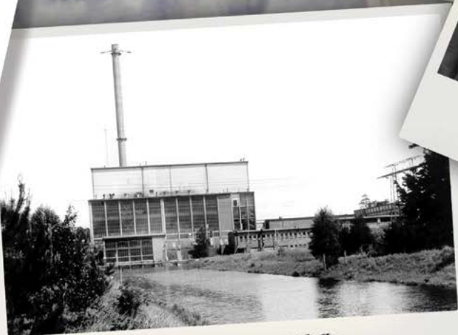
АЭС «Рейнсберг» (ТФР).
