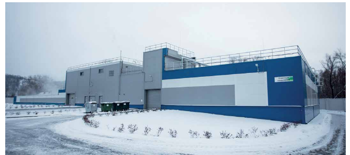
Биологические очистные сооружения промышленных стоков в Нижнем Новгороде, построенные по технологии Global Water Engineering
