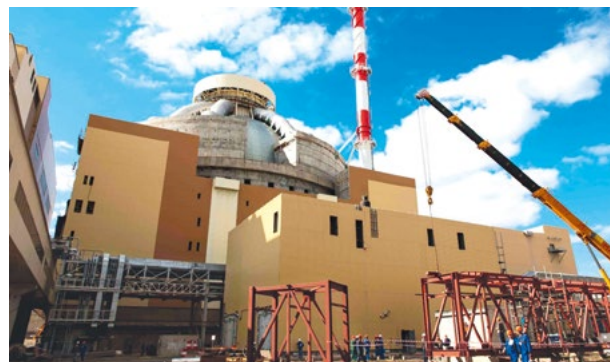
Энергоблок № 1 Нововоронежской АЭС-2
