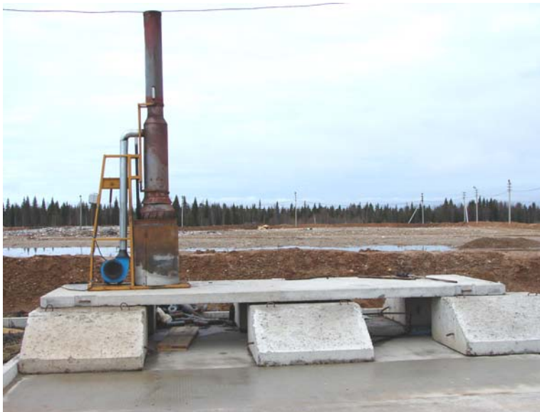
Установка по термической утилизации отходов «Факел», эксплуатируемая на полигоне Урдомского ЛПУМГ
