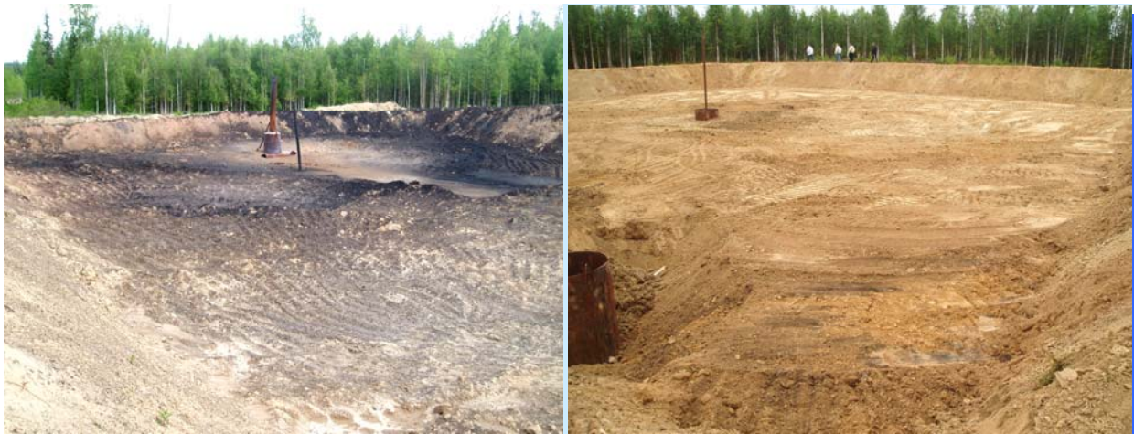
Факельный амбар на км 102 конденсатопровода «Вуктыл-СГПЗ» до и после проведения работ
