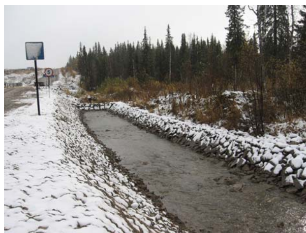
Фильтр отстойник на вдольтрассовом проезде МГ СРТО–Торжок
