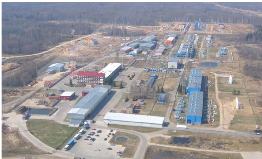
КС-18 Мышкинского ЛПУМГ
