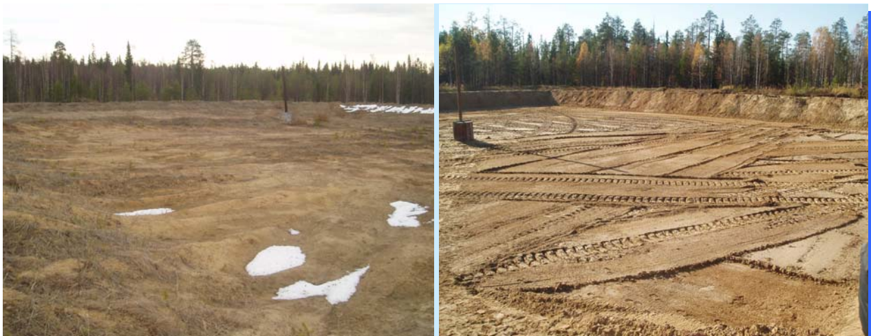
Факельный амбар на км 134 конденсатопровода «Вуктыл-СГПЗ» до и после проведения работ
