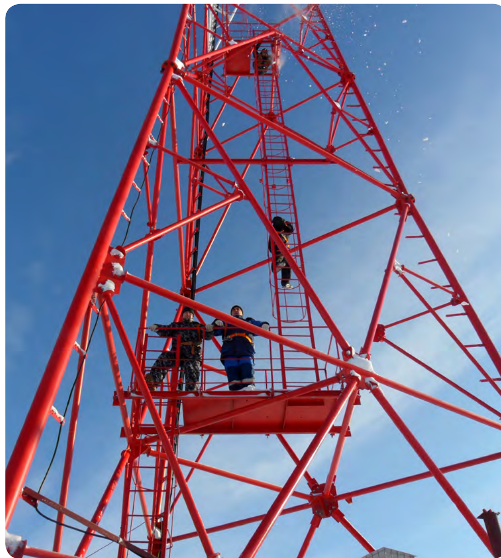
На фото: строительство базовой станции на горном хребте Уреньга в Челябинской области
