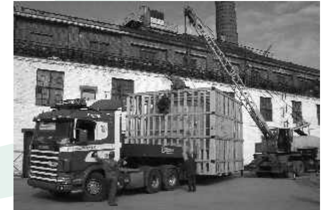
Разгрузка нового оборудования на КФОБ The unloading of the new equipment at KOPM
