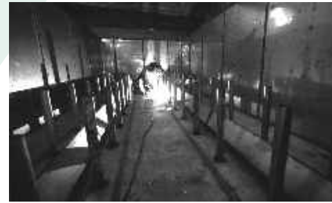
На стройплощадке нового целлюлозного производства НЦБК NPPM new pulp site
