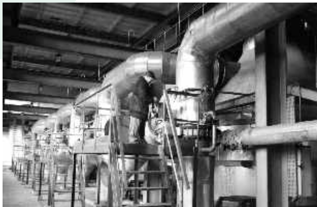
Вакуум-выпарная установка НЦБК Evaporating Station at NPPM
