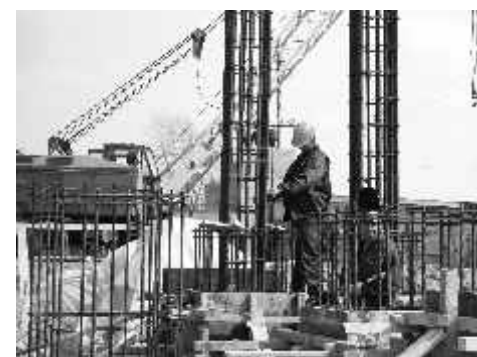
Сварочные работы во время монтажа оборудования на КФОБ
