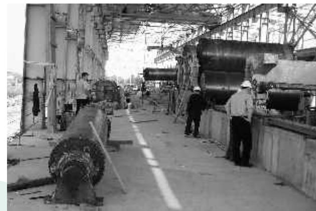
Начало монтажа БДМ-9 на НЦБК The mounting of the PM-9 at NPPM
