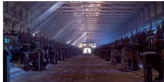
НОВОКУЗНЕЦКИЙ АЛЮМИНИЕВЫЙ ЗАВОД, ЦЕХ ЭЛЕКТРОЛИЗА
