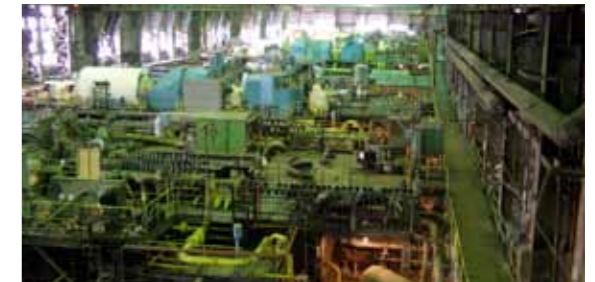
АЧИНСКИЙ ГЛИНОЗЕМНЫЙ КОМБИНАТ, ТУРБИННЫЙ ЦЕХ
