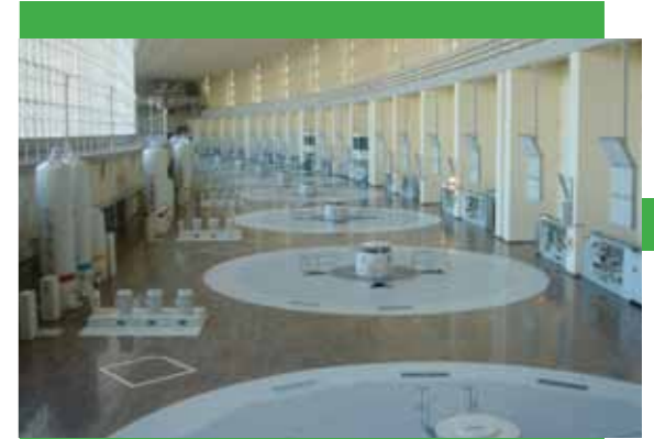
ТУРБИННЫЙ ЗАЛ САЯНО-ШУШЕНСКОЙ ГЭС
