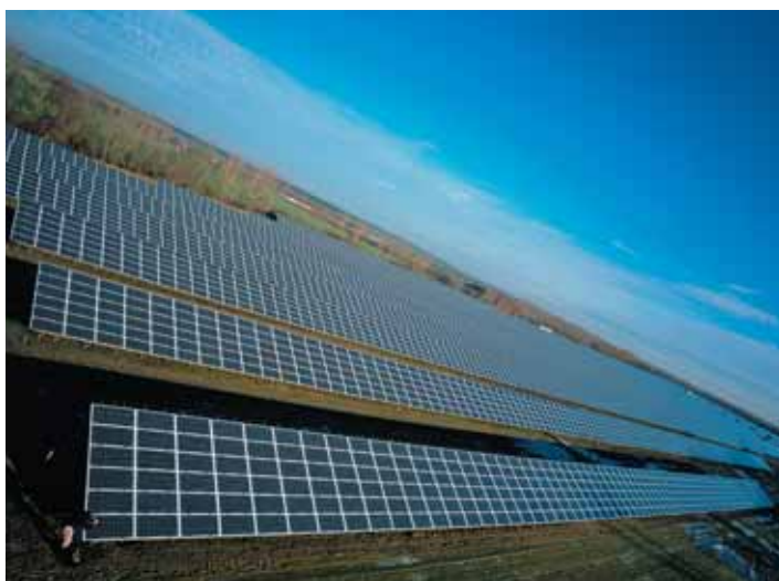
Крупнейшая в мире солнечная электростанция в Лейпциге (Германия).
