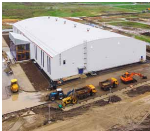
Строительство нового ледового дворца в Невинномысске
