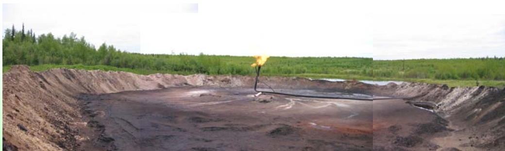
Газофакельная установка УКПГ-3 Вуктыльского ГПУ после ремонта
