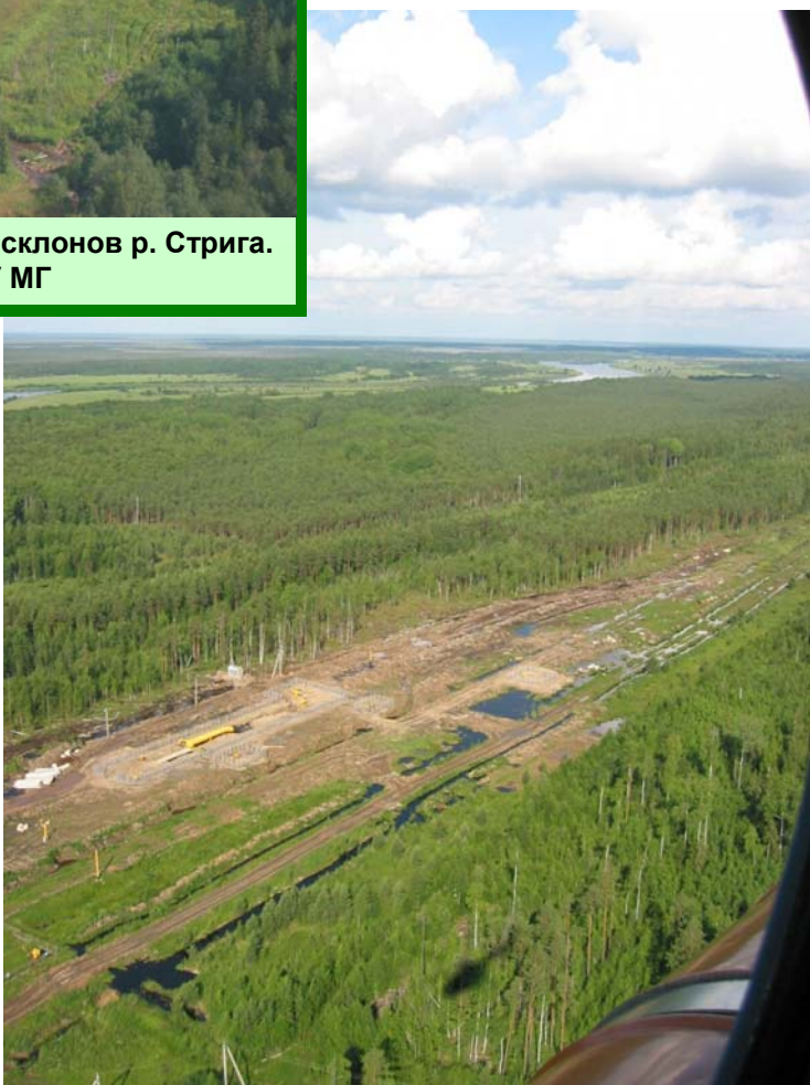
Камера запуска очистного устройства. Юбилейное ЛПУ МГ. Этапы рекультивации
