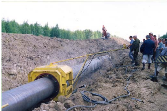
Контроль выполнения строительных работ на газопроводе
