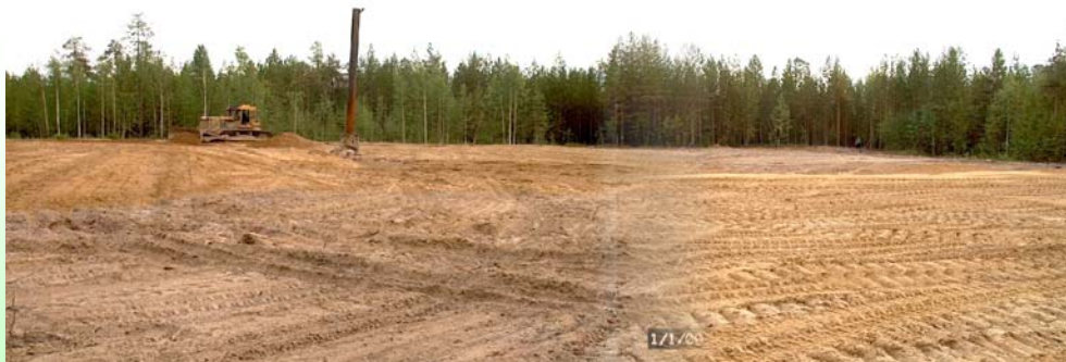
Техническая рекультивация амбара (июль 2003 г.)
