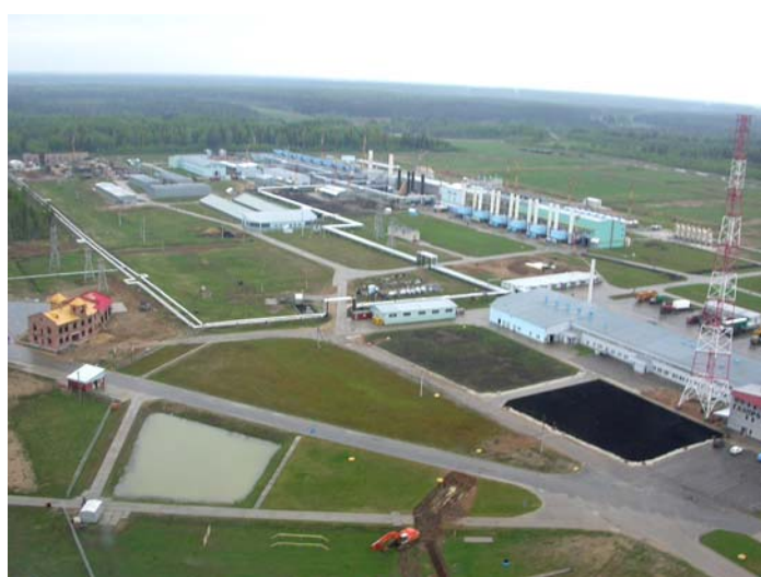
Компрессорная станция (п. Нюксеница)
