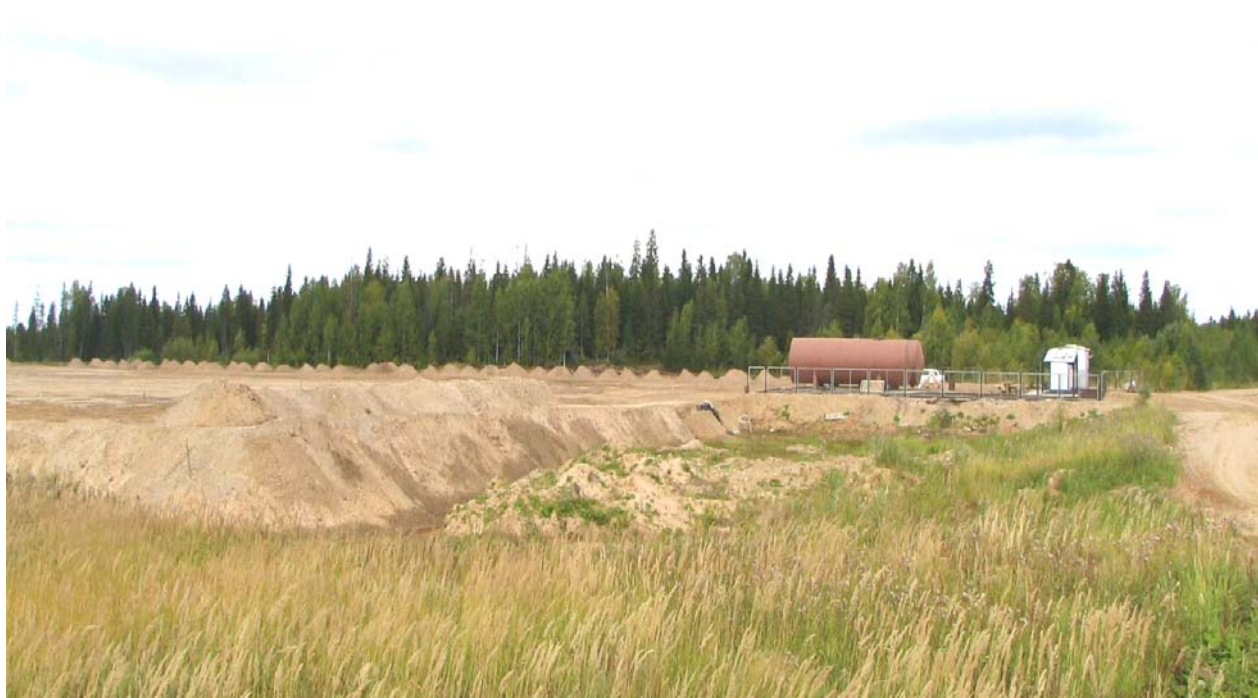
Строительство полигона (п. Урдома)
