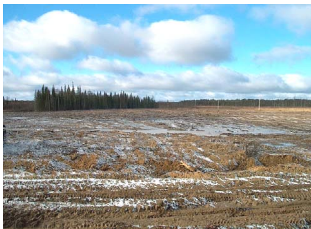
Ликвидация последствий аварии на 52 км конденсатопровода. Техническая рекультивация.
