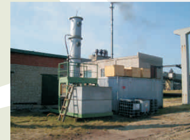
Пилотная установка по очистке сточных вод НЦБК и города Неман A Krofta outplant effluent treatment system to process the total NPPM discharges and the town of Neman sewage waters
