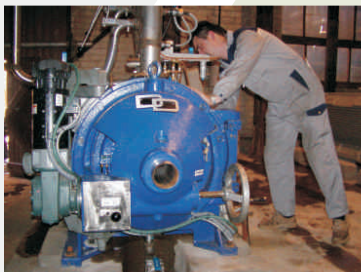
Монтаж мельницы GI&V на НЦБК NPPM GL&V mill assemblage
