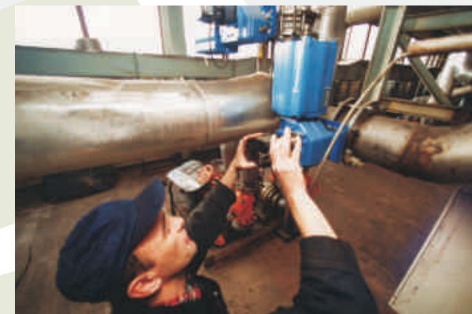
Установка регулирующей аппаратуры на БМ-8 НЦБК Installation of regulating technique on Paper Machine №8
