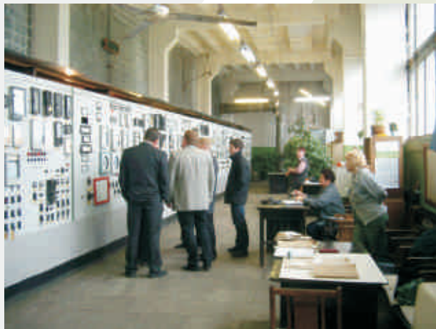
В котельной НЦБК At NPPM boiler house
