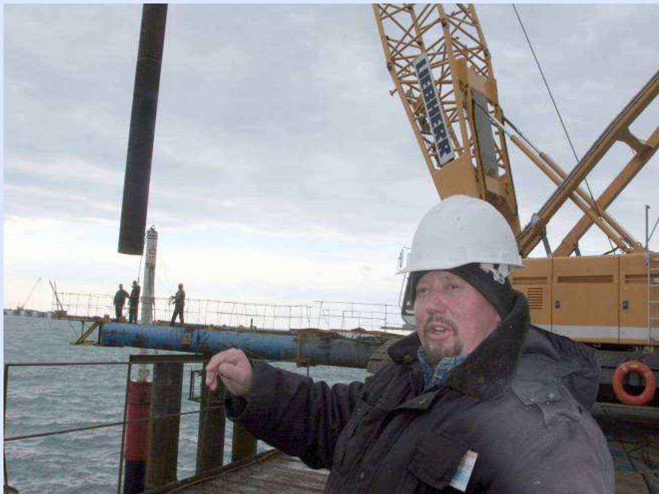
Строительство морской эстакады
