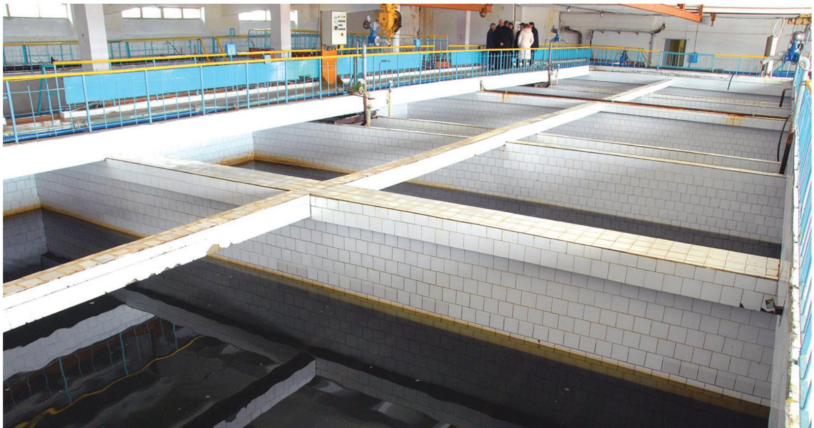
Для обеспечения бесперебойности и стабильности подачи воды используются емкости для накопления воды – 29 резервуаров с суммарным объемом 86,55 тыс. м<sup>3</sup>.
