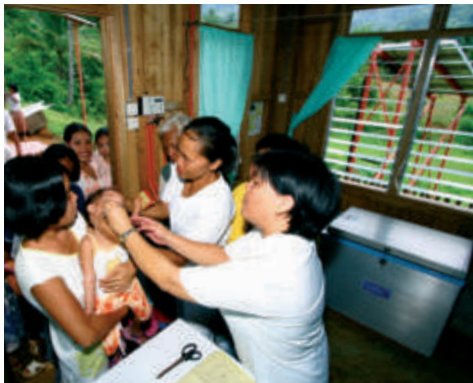
Холодильное оборудование для хранения вакцин, питаемое от солнечных батарей, в медицинском центре SPOTS Barangay на Филиппинах.
