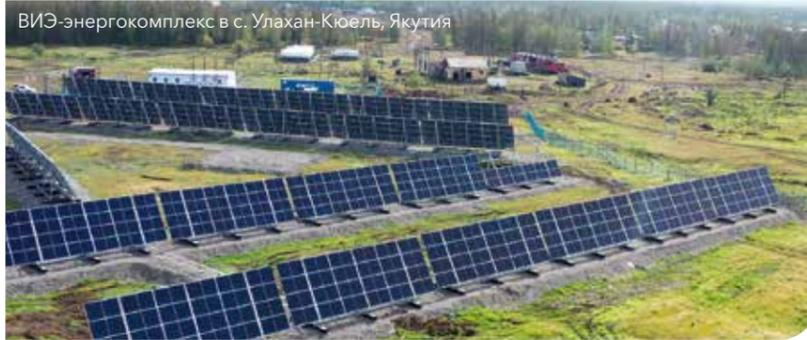
В Якутии Группа РусГидро ввела в эксплуатацию первый ВИЭ-энергокомплекс, построенный на основе энергосервисного договора. В его состав входят современная ДЭС (600 кВт), СЭС (400 кВт) и накопитель энергии мощностью 125 кВт, объединенные автоматизированной системой управления.
