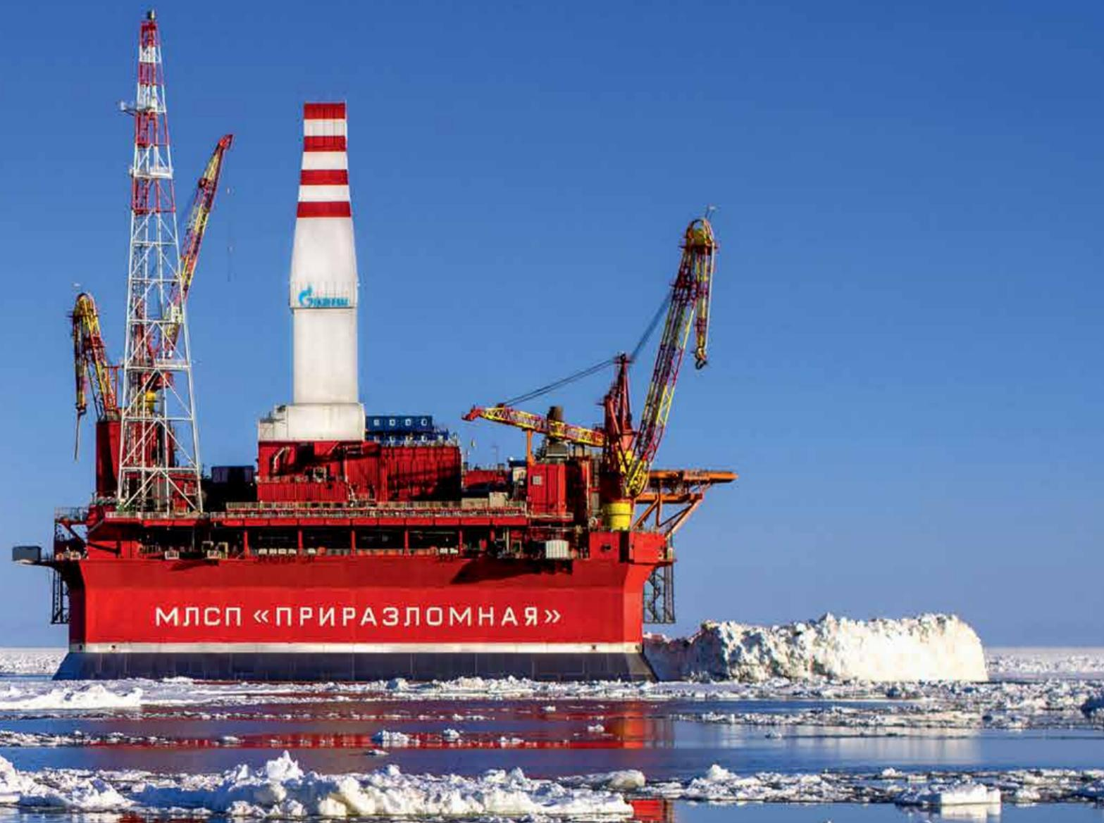
Риски, связанные с отгрузкой, также предельно минимизированы. Перекачка нефти из нефтехранилища платформы на танкеры происходит с помощью комплексов устройств прямой отгрузки нефти, расположенных на платформе. Для предотвращения разлива нефти в процессе перекачки отгрузочная линия оснащена системой аварийной остановки, позволяющей прекратить перекачку сырья в течение 7 секунд.
