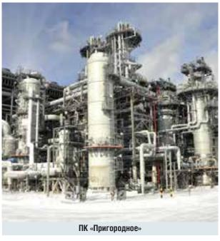
года. Завод, расположенный на участке площадью 490 гектаров, включает в себя две технологические линии номинальной производительностью 4,8 миллиона тонн СПГ в год каждая.
