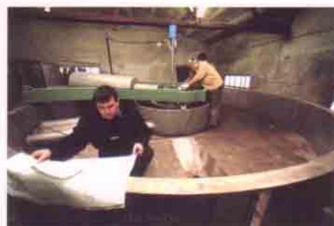
Установка флотаторов по очистке оборотной воды "KWI" на НЦБК
