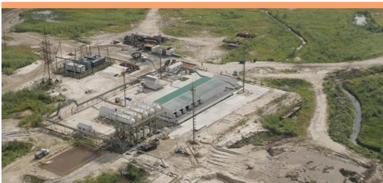
В 2007 году в ООО «РН-Юганскнефтегаз» в рамках Целевой экологической программы на полигоне в районе кустовой площадки № 56 Южно-Сургутского месторождения введена в эксплуатацию комплексная установка по переработке жидких и твердых нефтесодержащих шламов производительностью до 90 м<sup>3</sup> в сутки.
