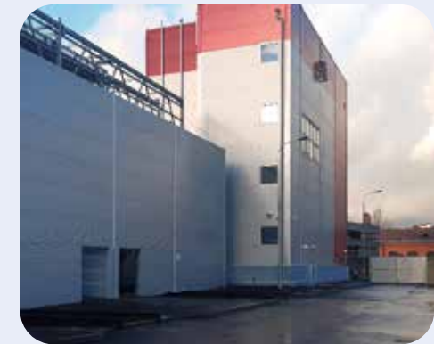
Строительство ПС 110 кВ Троицкая
