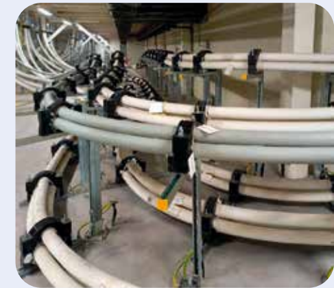
Строительство двух ЛЭП 110 кВ от ПС 330 кВ Звездная (Южная) до ПС 110 кВ Троицкая
