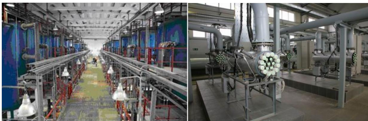
Фильтровальная станция с отделением ультрафиолетового обеззараживания
